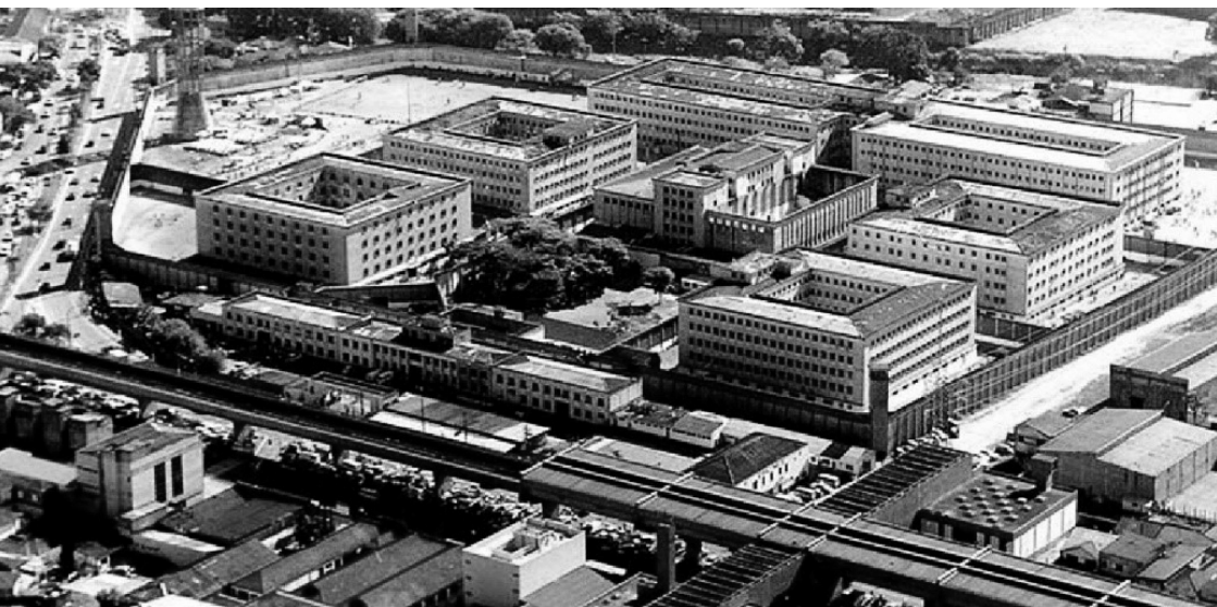
Figura 44. Vista aérea do Complexo do Carandiru, São Paulo.
