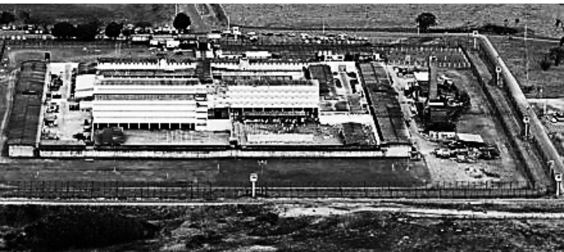
Figura 56. Vista aérea da Penitenciária Federal de Campo Grande, Mato Grosso do Sul, 2006.
